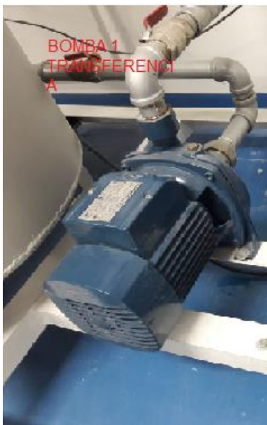
Fig. 10. Bomba centrífuga Pedrollo Cp620 – 1Hp
