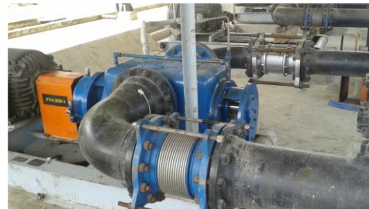
Fig. 1. Bomba de tornillo hillman.
