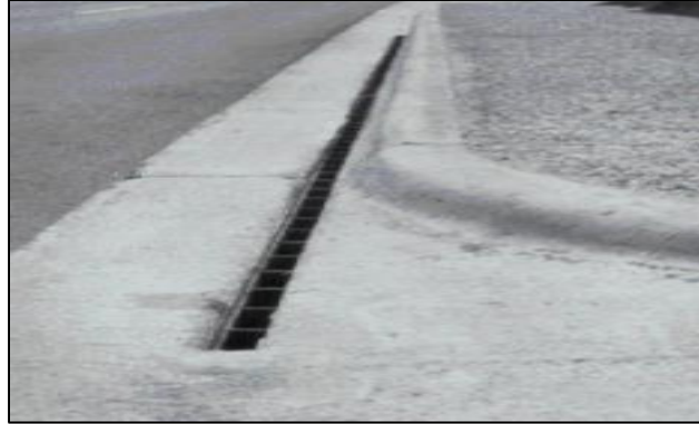
Figura 36. Entrada de drenaje ranurada en una intersección Fuente: (FHWA, 2013)
