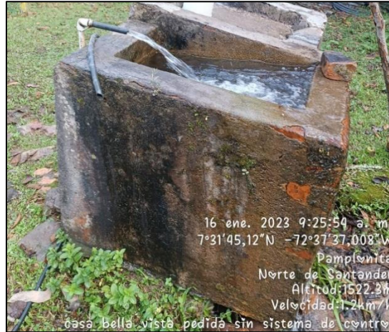
Ilustración 15. Tanque de almacenamiento Naciente “La Tigra”.
