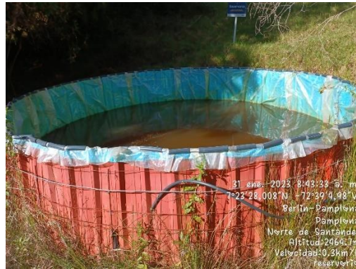
Ilustración 10. Tanque de almacenamiento.
