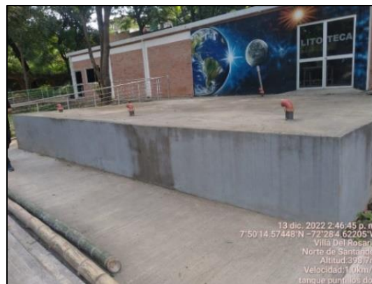
Ilustración 8. Tanques de almacenamiento 2.
