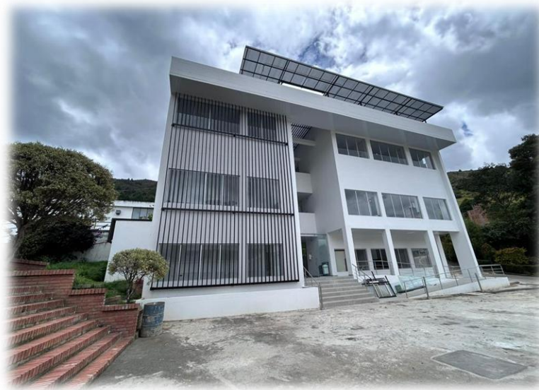
Ilustración 9.3. Bienestar Universitario Pamplona - Obra Ejecutada Vigencia 2022
