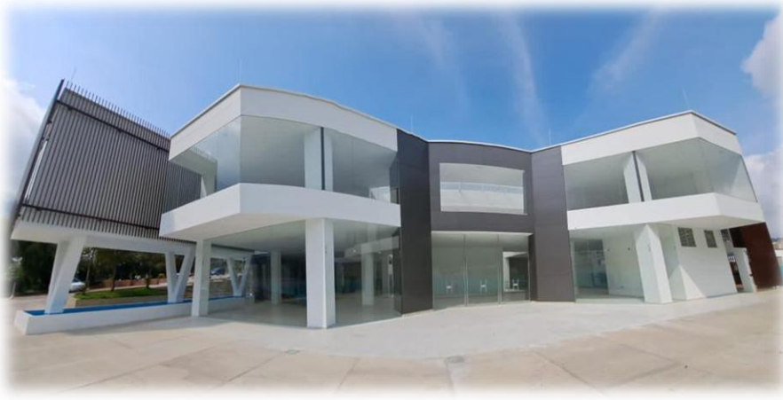
Ilustración 9.5. Nueva Biblioteca Campus Principal - Obra Ejecutada Vigencia 2022
