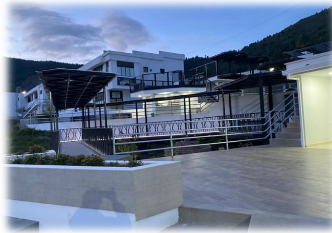
Ilustración 9.6. Plazoleta de cafeterías campus principal pamplona - Obra Ejecutada Vigencia 2022.
