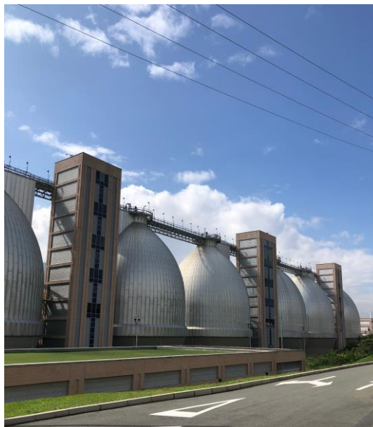
Tratamiento Preliminar Digestores de Lodos
