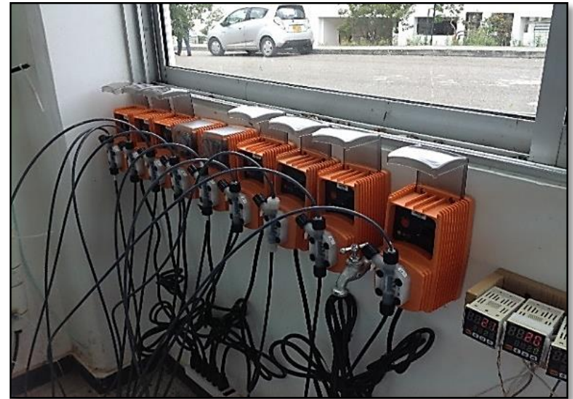
Foto: Equipos (bomba dosificadora de caudal 2i/h a 20bar (290 psi))
