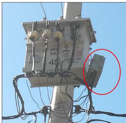
Figura 2. Analizador de red instalado (Fuente, Carrillo, 2020) Se observaron las fallas en los circuitos de distribución y se revisaron las posibles causas.
