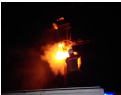
Figura 7. Emisión de gases por incendio en transformador desbalanceado (Fuente, Carrillo, 2020)
