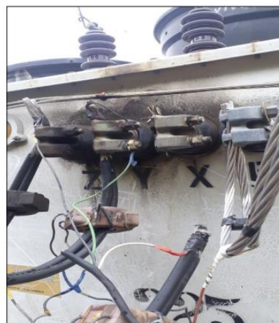
Figura 5. Interrupción de circuito por punto caliente (Fuente, Carrillo, 2020)
