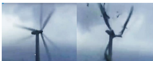
Figura 1. Destrucción de una turbina eólica por velocidades del rotor muy por encima del valor nominal.
